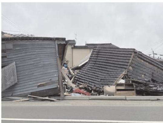
写真 1 輪島市の倒壊した一般家屋
