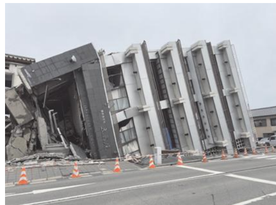
写真 2 輪島市の倒壊した低層ビル
