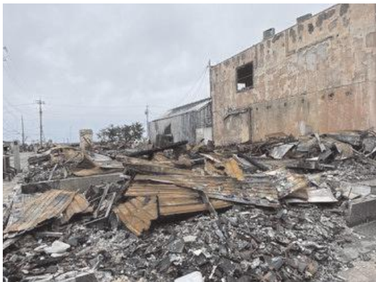
写真 3 輪島市朝市の火災被災地
