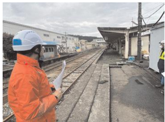
写真8 のと鉄道の被災状況調査
