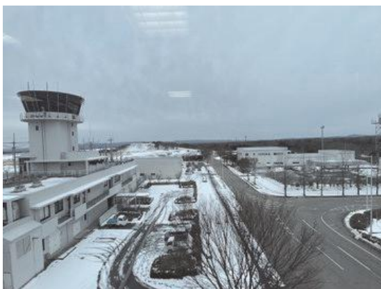
写真7 のと里山空港の滑走路被災状況
